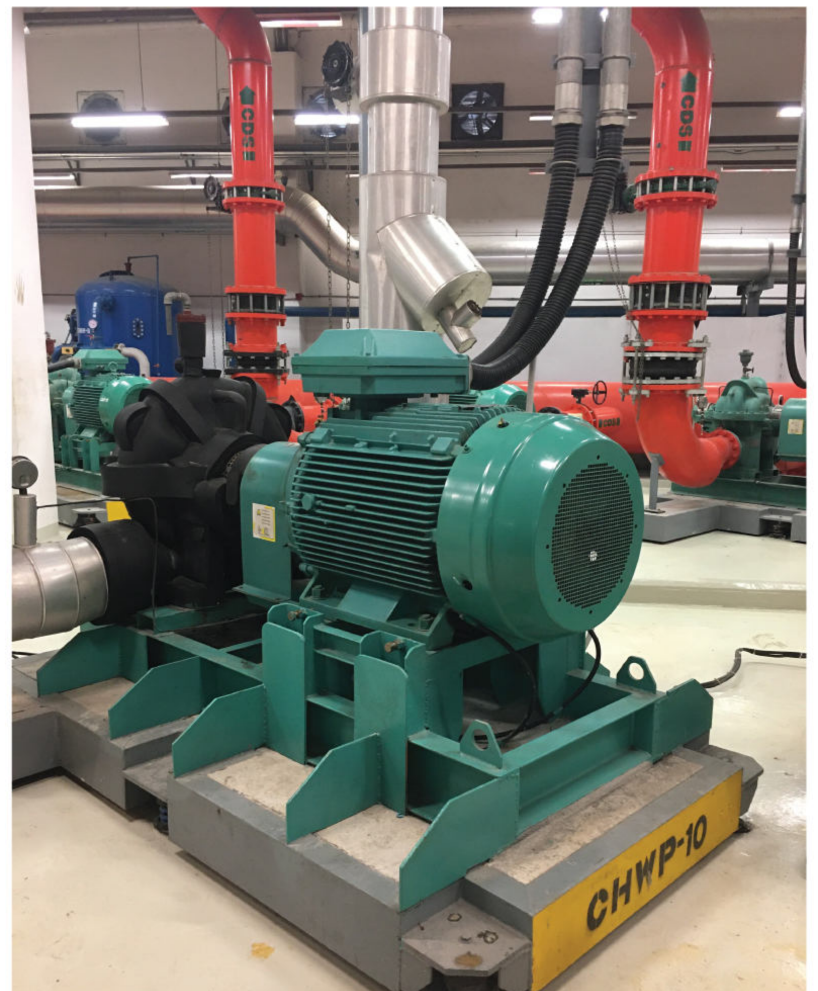
Water pump อุปกรณ์หลักที่ใช้ร่วมกับ star-delta
